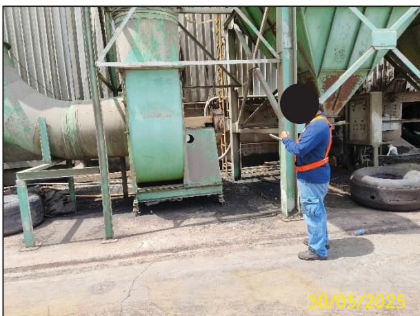
เจ้าหน้าที่ตรวจสอบสภาพและบำรุงรักษาระบบกำจัดฝุ่น (Bag Filter)
