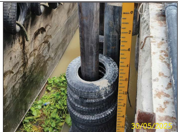
ค) การติดตั้งเสาไม้ตามมาตรฐานระดับน้ำบริเวณหน้าท่า
