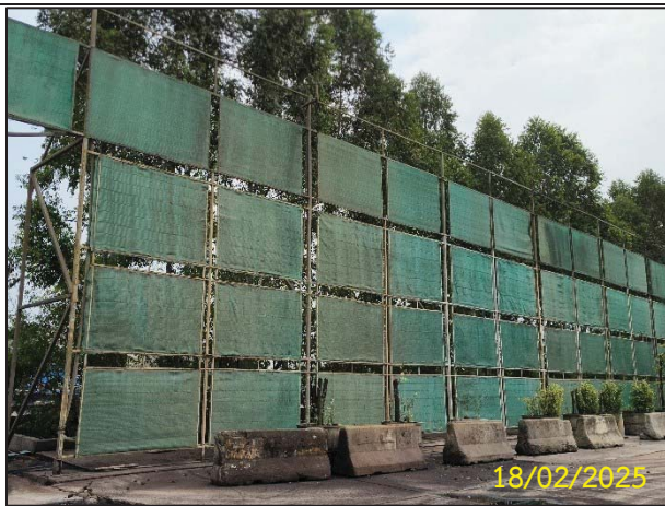
มีการติดตั้งกำแพงกันลมบริเวณพื้นที่ขนถ่ายถ่านหิน เพื่อลดการฟุ้งกระจายของฝุ่นจากถ่านหิน
