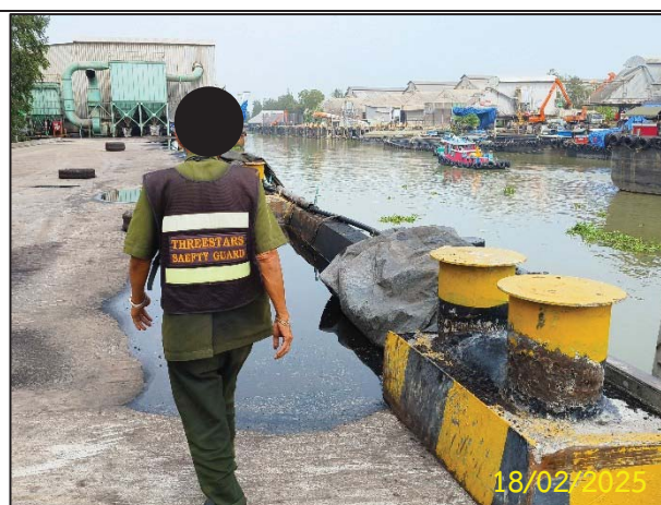
ง) พนักงานคอยตรวจสอบสภาพอุปกรณ์สภาพ หลักผูกเรือ และยางกันชนเรือบริเวณท่าเทียบเรือ
