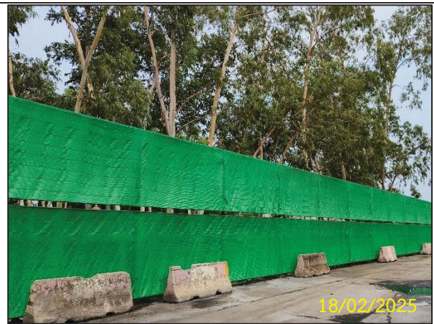
มีการติดตั้งกำแพงกันลมบริเวณพื้นที่ขนถ่ายถ่านหิน เพื่อลดการฟุ้งกระจายของฝุ่นจากถ่านหิน
